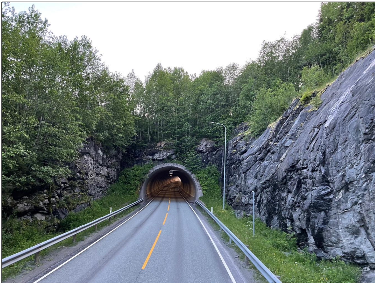
Foto 1. Oversikt forskjæring sørøst. Det er mye vegetasjon over og langs ved tunnelportalen.
