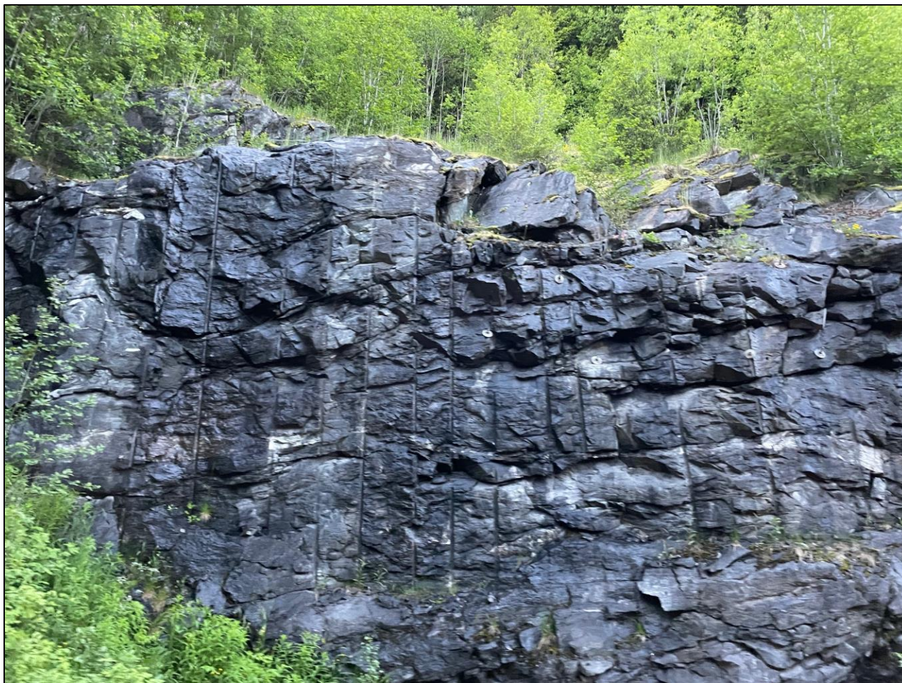
Foto 5. Oversikt forskjæring sørøst, høyre side. Det er registrert spredte bolter i forskjæringen.
