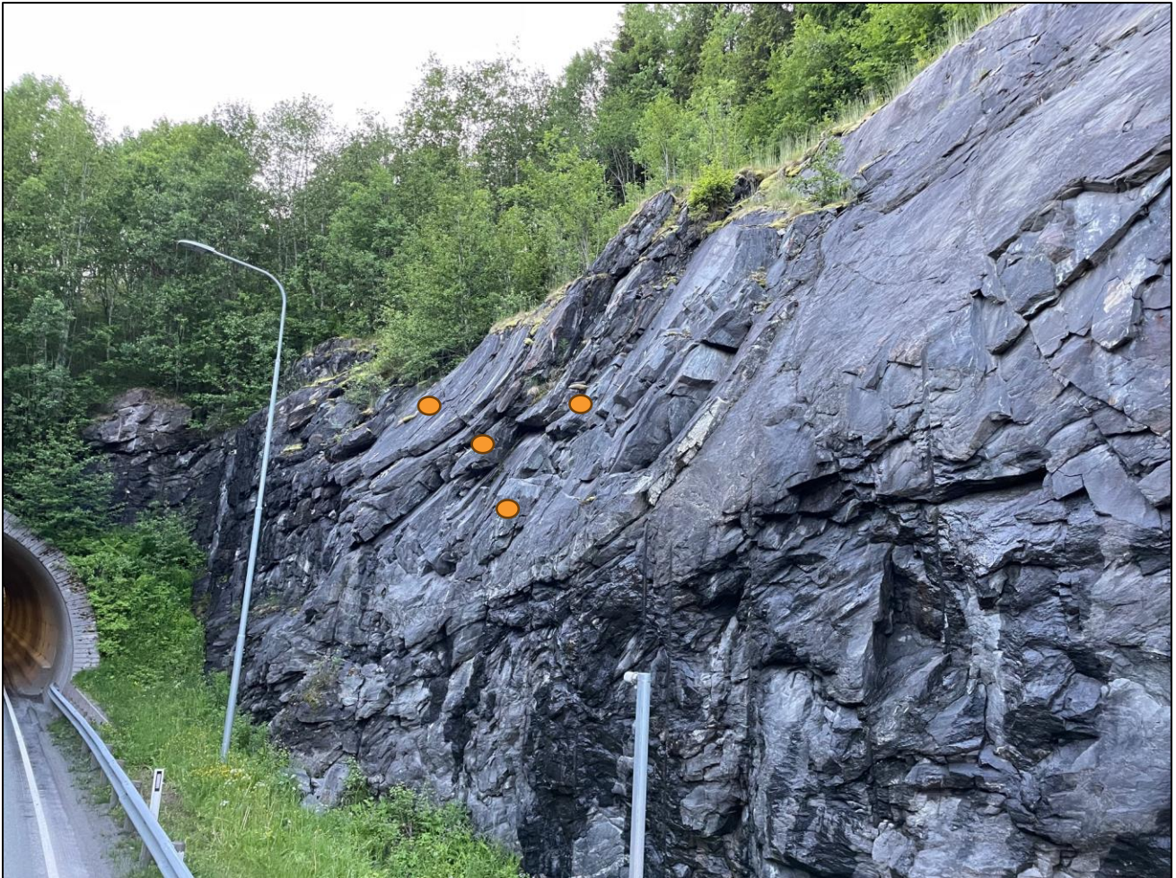
Foto 4. Oversikt forskjæring sørøst, høyre side. Omtrentlig bolteplassering vist i oransje. Anvisning av bolter utføres av geolog på stedet. Anslår ca. 4-5 stk spredte bolter, men antall må vurderes nærmere.
