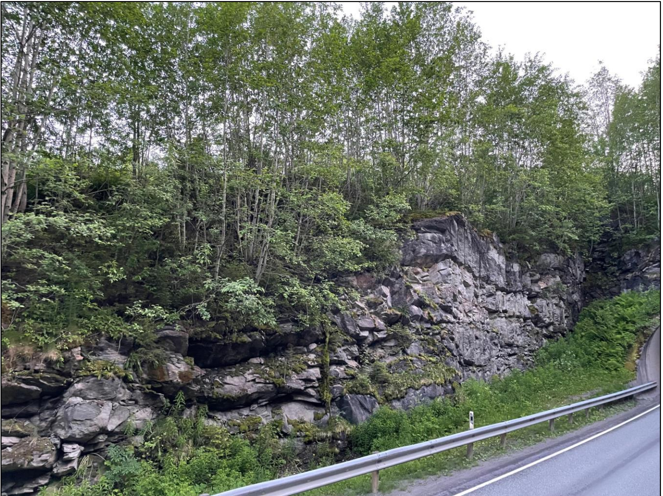
Foto 3. Oversikt forskjæring sørøst, venstre side. Det er ikke vurdert behov for ytterligere sikringstiltak. Grøftebredden er tilstrekkelig bred for mindre nedfall.
