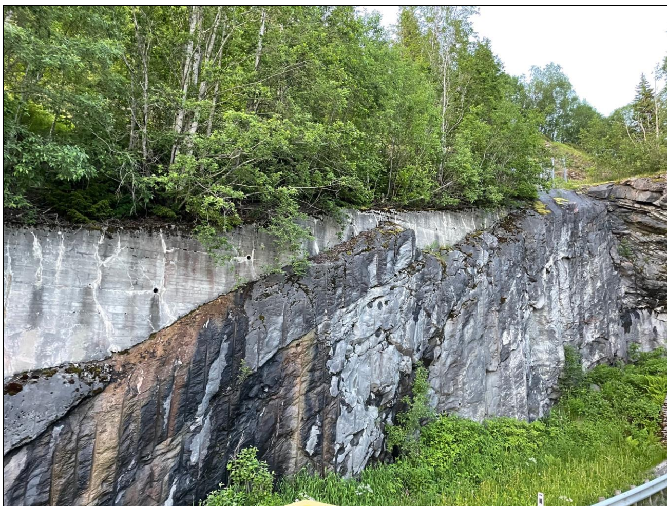
Foto 8. Forskjæring i nordvest, venstre side. Stabilisert med betongmur. Grøftebredden er vurdert som tilstrekkelig.
